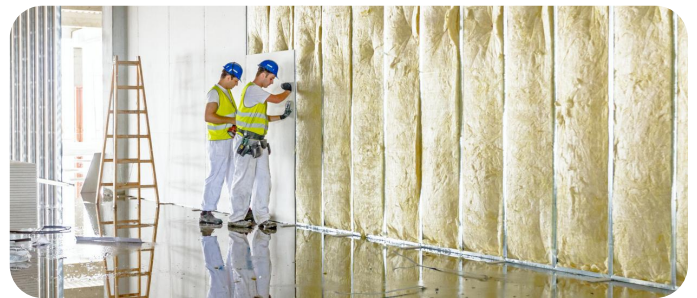
04 – Isolation Gros œuvre
